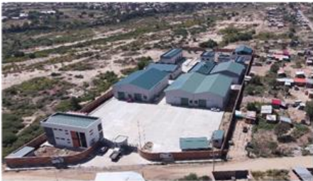
Vista panorámica de la planta
